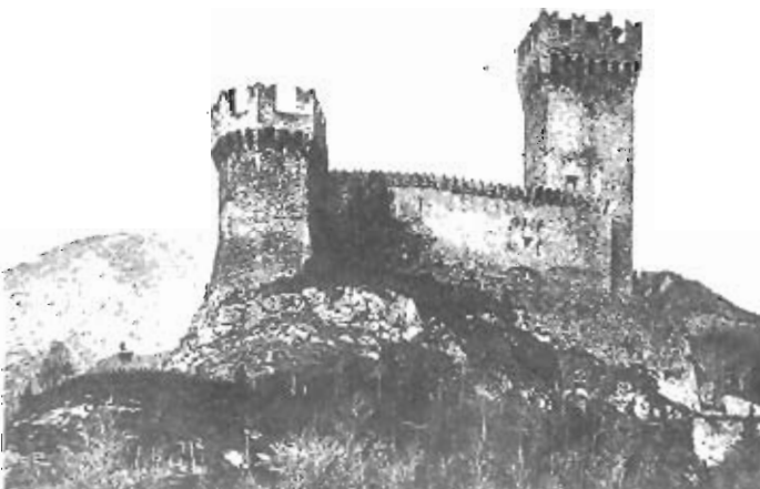
Dall'alto: La rocca di Arquata prima del restauro; da una vecchia foto del 1880. — La rocca durante i lavori di restauro del "MASTIO" (da notare la rozza e caratteristica impalcatura volante). — Lavori di ristrutturazione della "cortina" (tratto che collega le due torri). — La fortezza immediatamente dopo i lavori.
