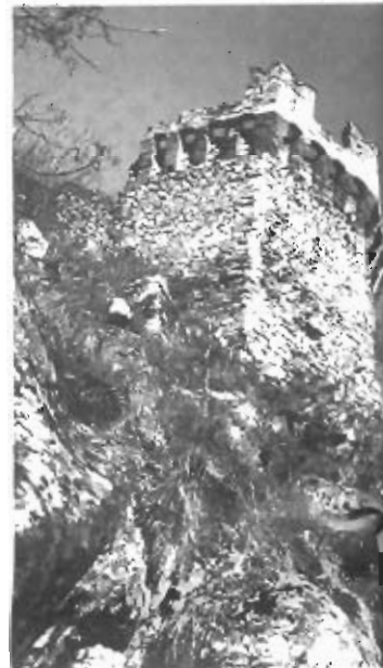
A sinistra in alto: Oggi, 100 anni dopo la ristrutturazione e già sommersa dal verde. — A sinistra in basso: l'interno del forte dominato dal "Mastio". — Sopra: Parte della "cortina" (da notare i "gattoni" in pietra sporgenti che reggevano il piano di ronda) — Particolare del "Mastio" con apparato aggettante per sistema difensivo piombante. — A fianco a destra: Il torrione semicircolare a scarpata (da notare lo stato precario del manufatto che necessita di urgenti interventi di restauro).
