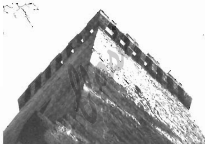
A sinistra in alto: Oggi, 100 anni dopo la ristrutturazione e già sommersa dal verde. — A sinistra in basso: l'interno del forte dominato dal "Mastio". — Sopra: Parte della "cortina" (da notare i "gattoni" in pietra sporgenti che reggevano il piano di ronda) — Particolare del "Mastio" con apparato aggettante per sistema difensivo piombante. — A fianco a destra: Il torrione semicircolare a scarpata (da notare lo stato precario del manufatto che necessita di urgenti interventi di restauro).
