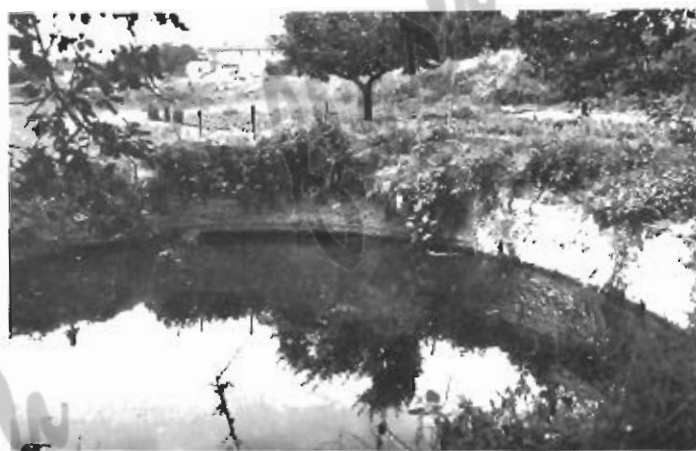
La grande vasca in opera cementizia (piscina epuratoria) attribuita alle abluzioni rituali del tempio, oggi comunemente denominata: "Il bagno della regina".
