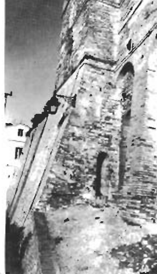
Resti di una torre con basamento a scarpa.
