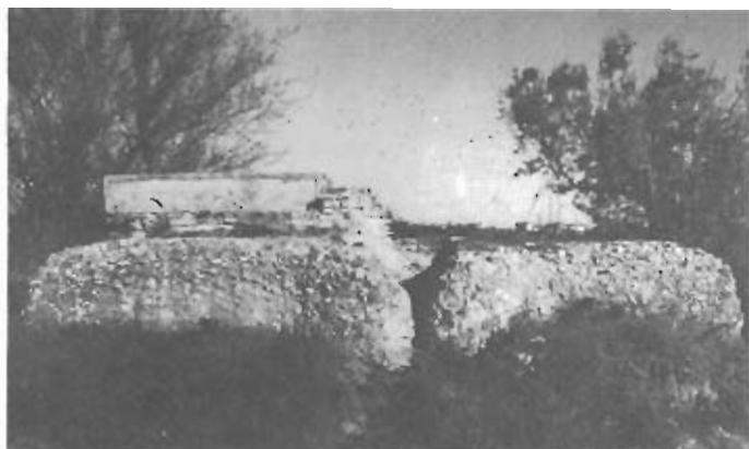
Sopra e sotto: Colle Cese di Castel di Lama: cisterna a due navate con volta a botte. - Pozzo per il prelievo delle acque.
