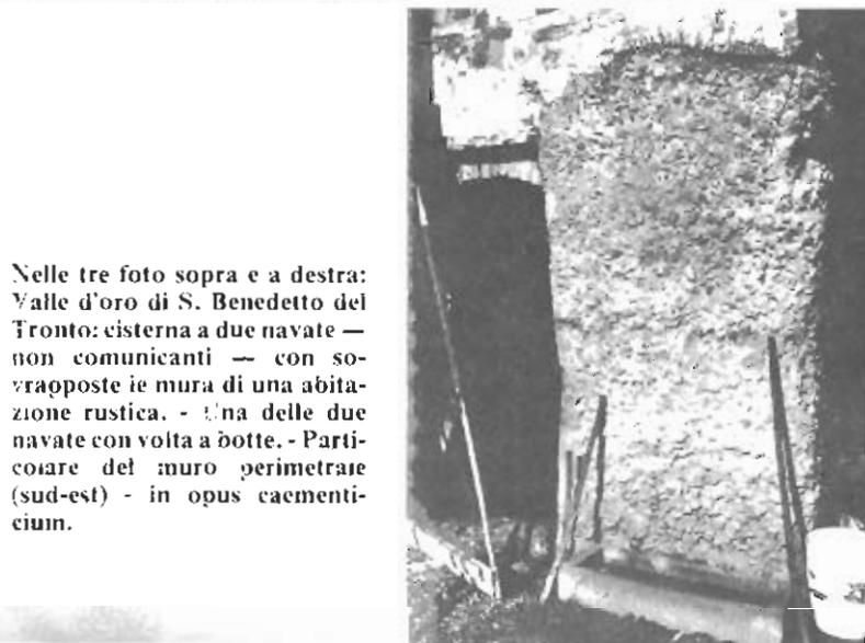
Nelle tre foto sopra e a destra: Valle d'oro di S. Benedetto del Tronto: cisterna a due navate - non comunicanti - con sovrapposte le mura di una abitazione rustica. - Una delle due navate con volta a botte. - Particolare del muro perimetrale (sud-est) - in opus caementicium.
