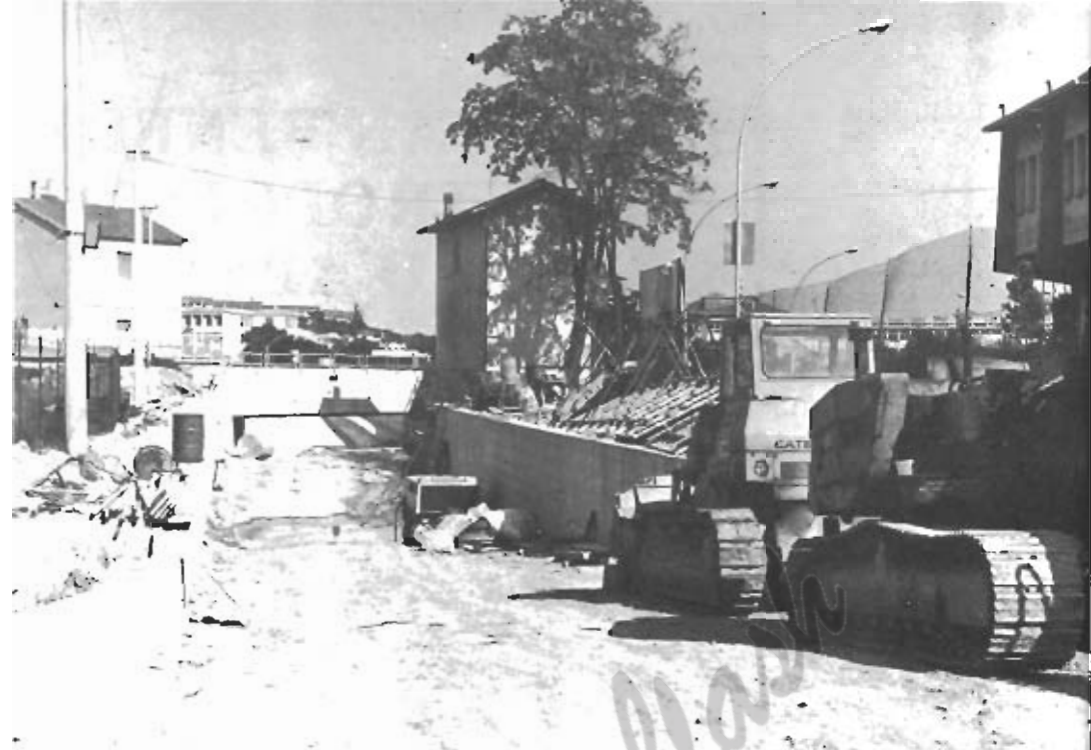
Il sottopasso nei pressi dell'Istituto Agrario di prossima apertura.
