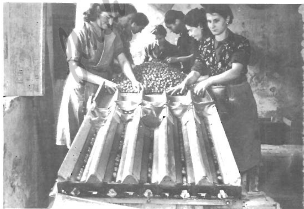
Le foto: Anno 1948 il laboratorio di Antonio Mazzocchi in piena attività: apparecchiatura per la scelta delle diverse pezzature.
