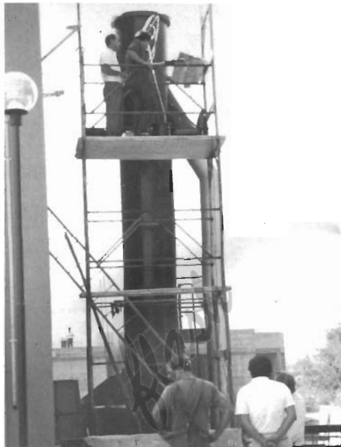
Il "camino", alto circa metri 8. Elemento determinante per il completo abbattimento dei fumi nocivi.
