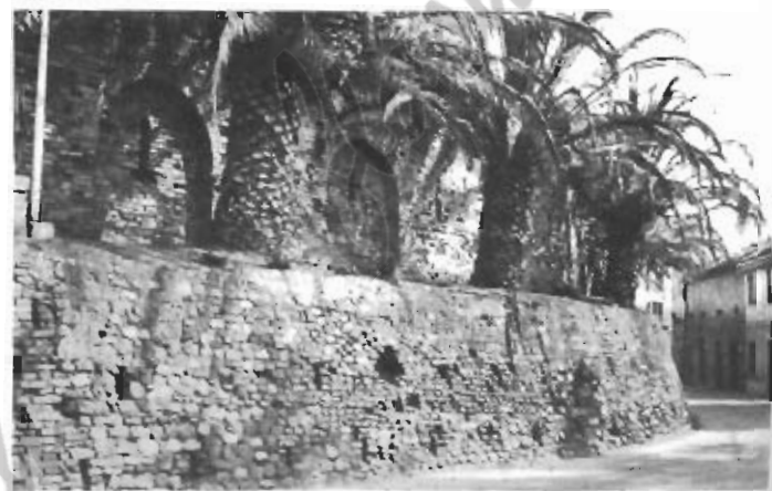
Le due foto: Le forme campanarie di "Terra Nuova" ■ Il muraglione sostruttivo del "Girone", costruito nel 1489 dal Maestro Matteo di Giovanni di Novata. Visibili le feritoie per la defluizione delle acque.
