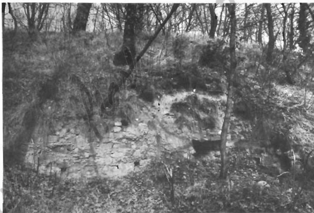
Sopra: Monte Passillo: ruderi in conci litici (XII-XIII sec). ■ Sotto: le vestigia del versante sud di Monte Passillo. Si noti l'accentuata prominenza all'infuori della parte destra e le rozze buche pontate. Questo tratto del Girone denuncia che le mura erano a piombo e intervallate da torri rompitratta.
