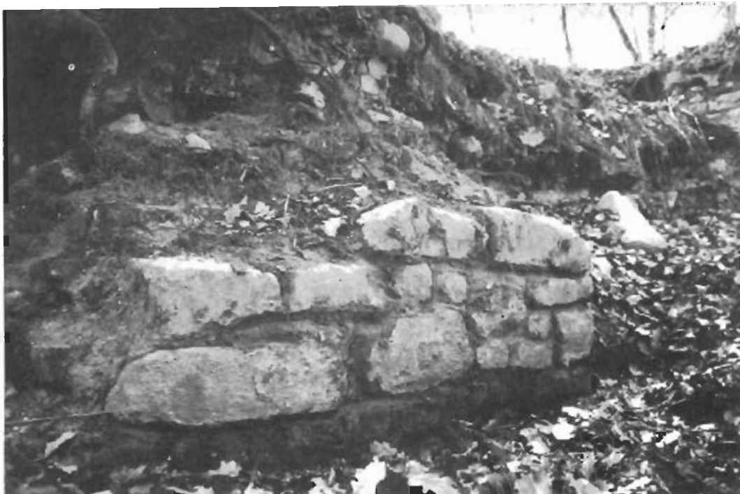
Sopra: Monte Passillo: ruderi in conci litici (XII-XIII sec). ■ Sotto: le vestigia del versante sud di Monte Passillo. Si noti l'accentuata prominenza all'infuori della parte destra e le rozze buche pontate. Questo tratto del Girone denuncia che le mura erano a piombo e intervallate da torri rompitratta.
