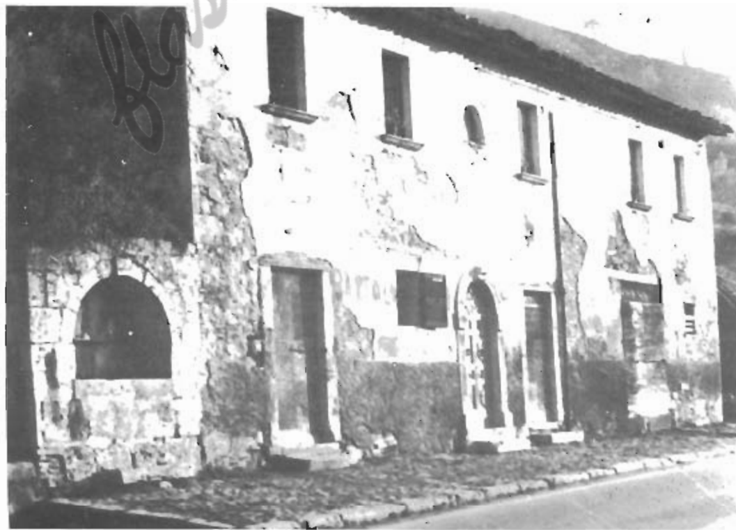
"L'osteria della Ciuca", alla sommità del dosso della strada Salaria, nei pressi di Mozzano, in una foto eseguita prima della ristrutturazione.
