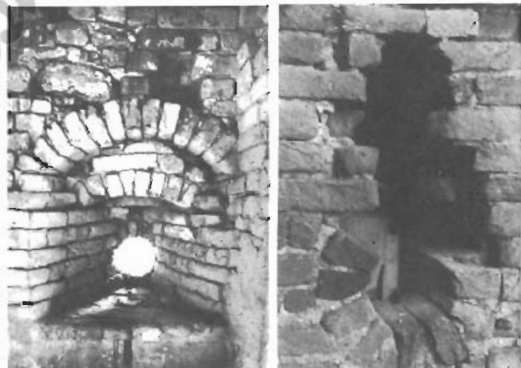
In alto: la cannoniera con orificio circolare acconciata con laterizi disposti a raggiera. ■ Qui sopra: interno della cannoniera o troniera ■ - La troniera seriamente compromessa.
