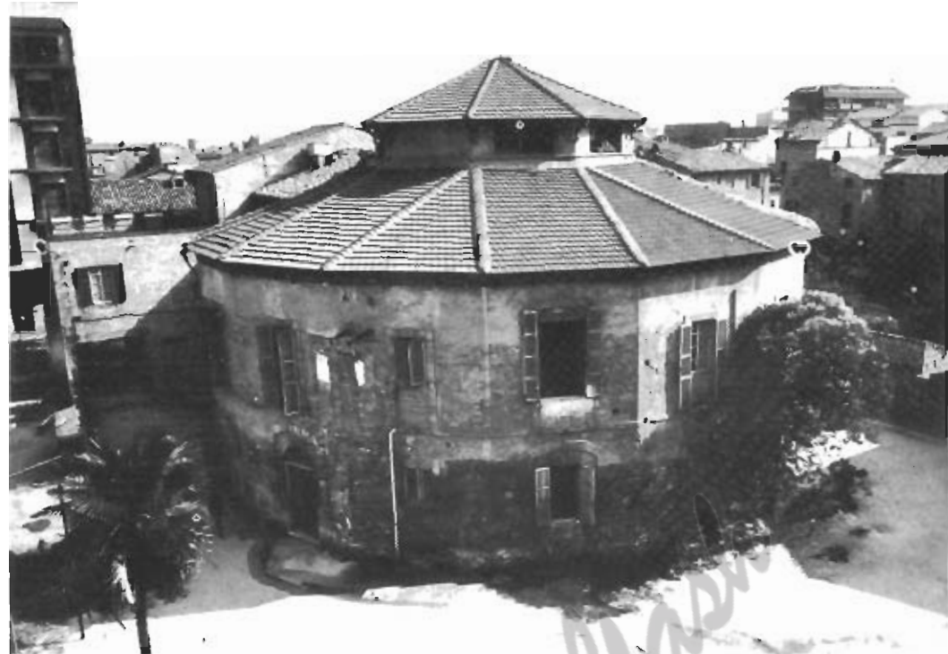
vecchia struttura ospedaliera a forma ottagonale, demolita nell'agosto del 1972 (foto Baffoni).
