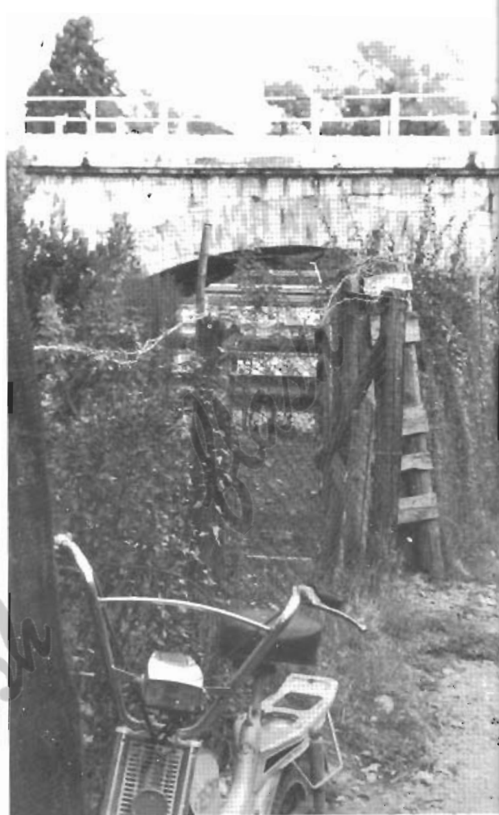
Il ponte della ferrovia a valle del ponte del Gran Caso come si presenta oggi.
