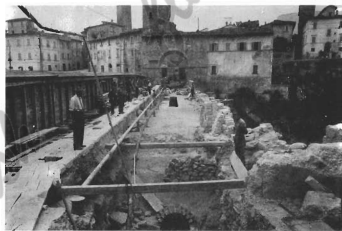
Veduta del camminamento durante le ultime fasi del lavoro di consolidamento.
