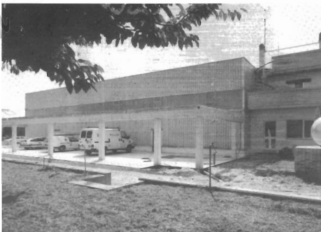
Lavori in corso per l'ampliamento dello stabilimento.
