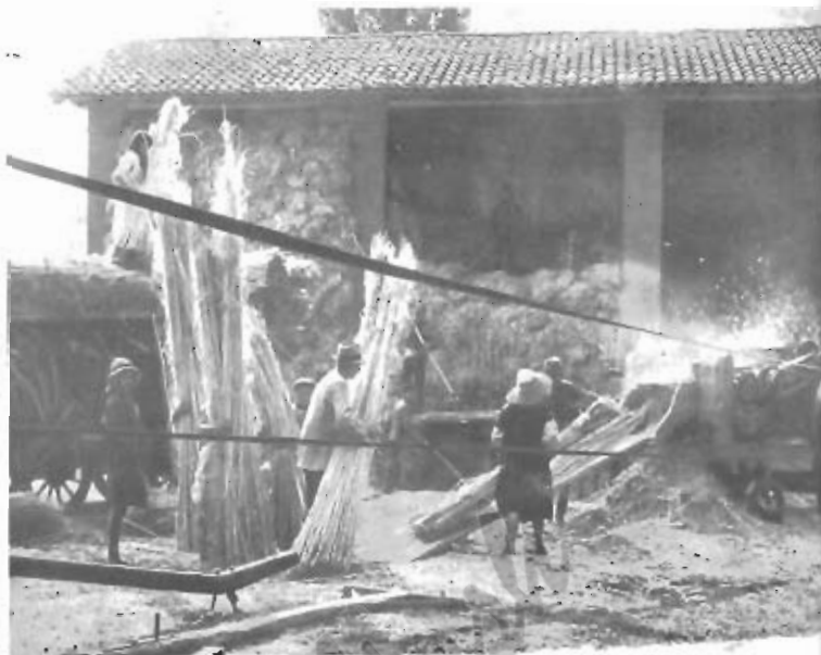
A fianco: la "rottura" o "macincolatura" eseguita a mano con la macingola. ■ Sopra: la scavezzatura della canapa effettuata, negli ultimi anni, a macchina.
