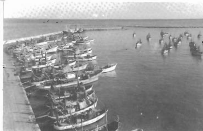
Dall'alto: relitto di una nave danneggiata da un bombardamento. ■ Progetto della Regione Marche per la realizzazione di "moletti" da adibirsi all'attracco di barche da diporto. ■ Panoramica del prolungamenti dei due moli.
