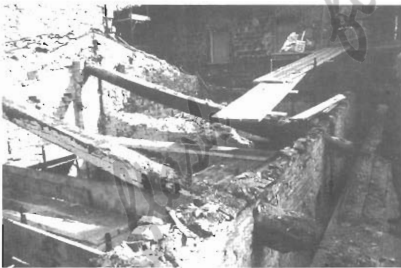
Le foto. A fianco: demolizione del tetto nella zona posteriore del complesso teatrale. ■ Sotto: realizzazione della barriera anti-umidità realizzata mediante immissione di resine. ■ Sopra: consolidamento delle murature mediante maglia di ferro e punzoni, completata con gettate in cemento
