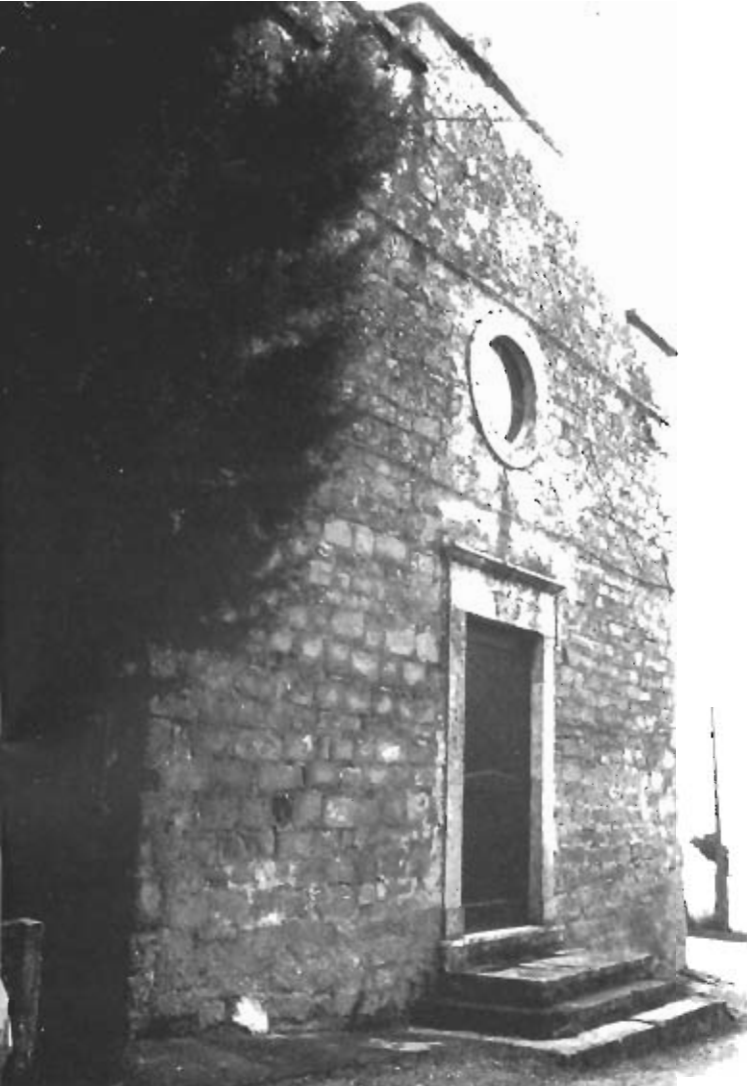
Montadamo: facciata della chiesa di S. Michele Arcangelo, sec. XVII
