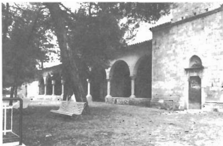
Portico frontale del "Convento dell'Annunziata" prima dell'inizio dei lavori di risanamento
