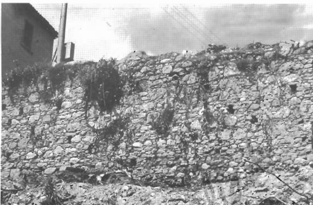
Muro di sostruzione in località Villa Pigna - Datazione incerta
