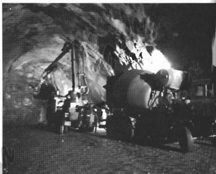
Sopra: Spritz-Beton sullo scavo in avanzamento della galleria ■
