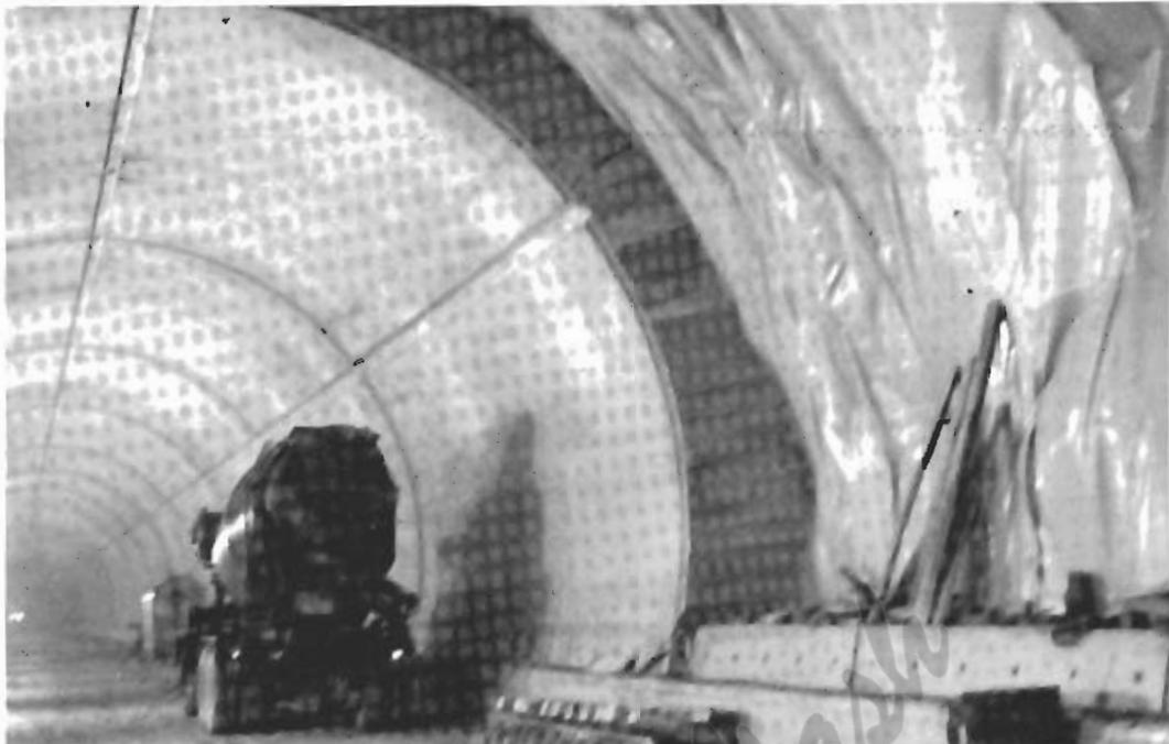
Impermeabilizzazione galleria con telo PVC prima del rivestimento in cemento armato
