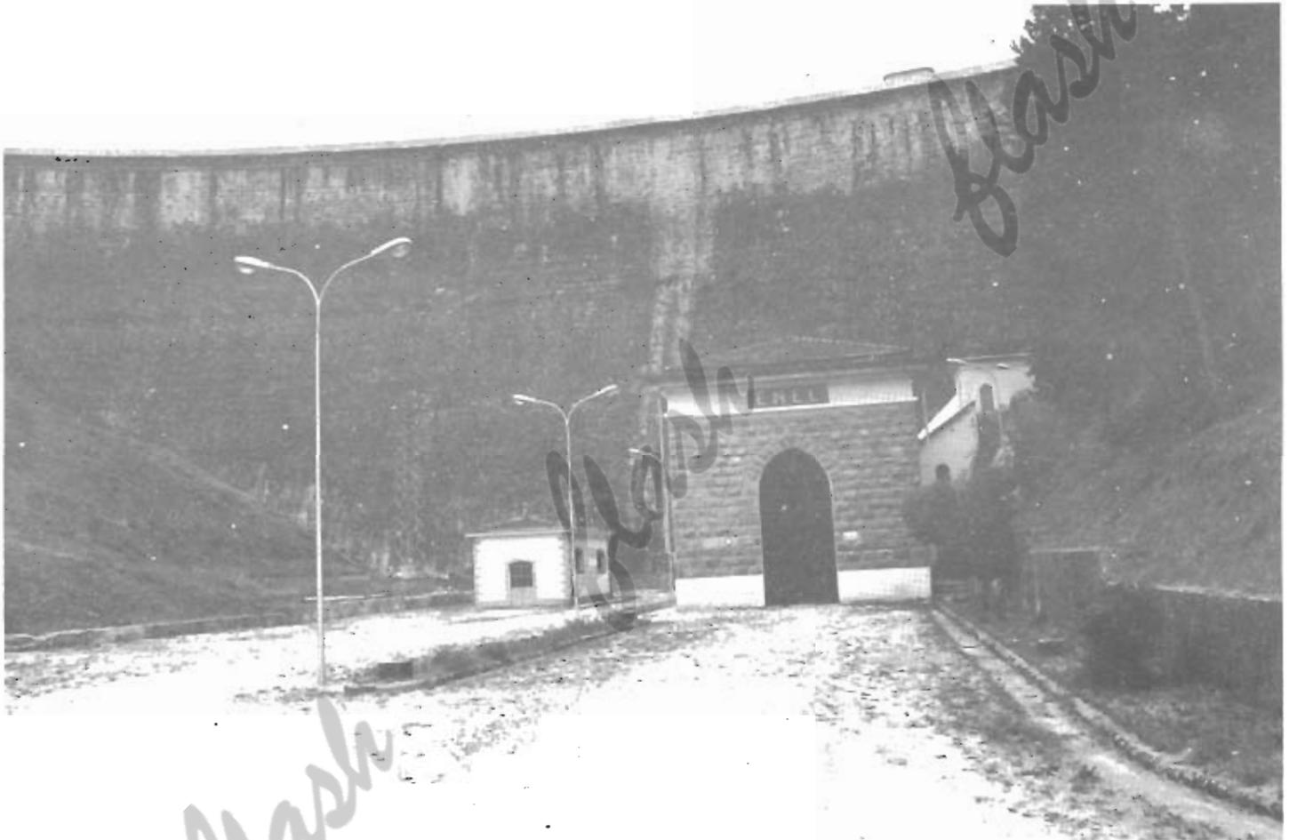
La diga vista dal basso. Si evidenzia il fabbricato della centralina idroelettrica, della potenza di 4.000 kW, le cui attrezzature furono completamente distrutte dai tedeschi in ritirata.
