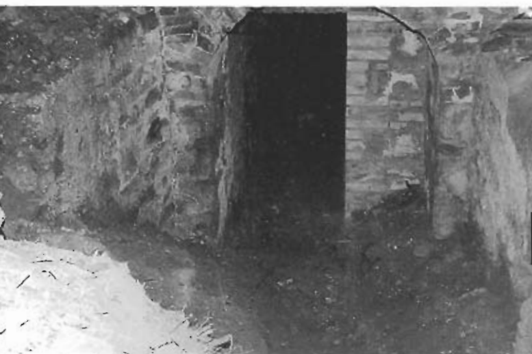
Scuola S. Domenico (già convento); tratto di galleria sotto l'ala Sud del fabbricato, ingresso nel locale a sud-est del piano interrato sul lato sud dell'edificio; dopo il primo tratto orientato nord-sud, la galleria si dirama in cinque tronconi ostruiti (Rif. 5)
