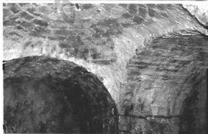
Le tre foto: tratto di galleria sotto la scuola di S. Domenico - ala sud del fabbricato, uno dei tronconi ostruiti. Da Nord in prossimità dell'incrocio. Copertura a voltina nell'incrocio (Rif. 5)
