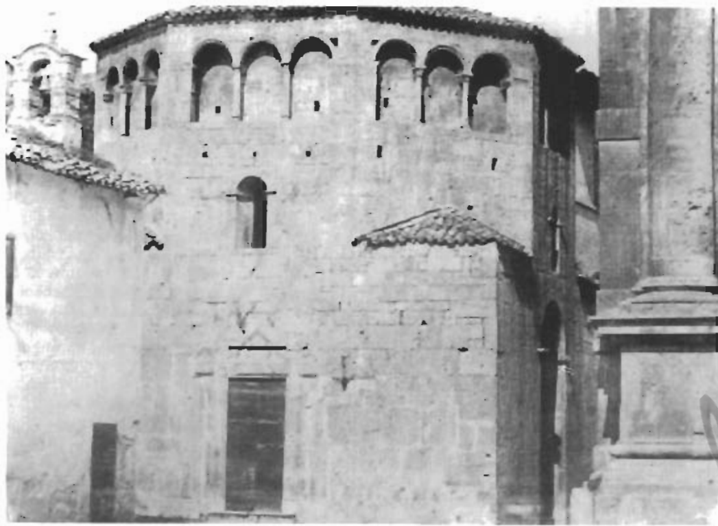
Scorcio della Chiesa di S. Biagio addossata al Battistero. Demolita nel 1886 per collegare il traffico urbano est-ovest
