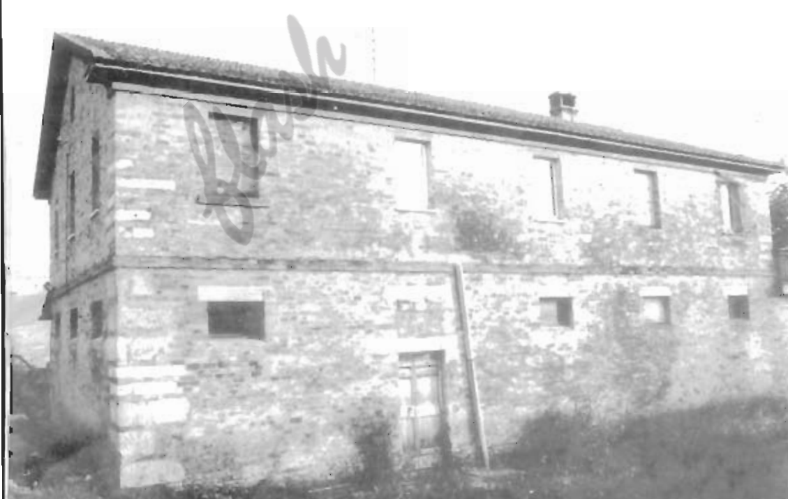
Ciarulli, strada per Spinetoli: abitazione rurale costruita con le pietre del torrione di Castel Vecchio. Riconoscibili le cornici di davanzale descritte dal Serra nel 1934
