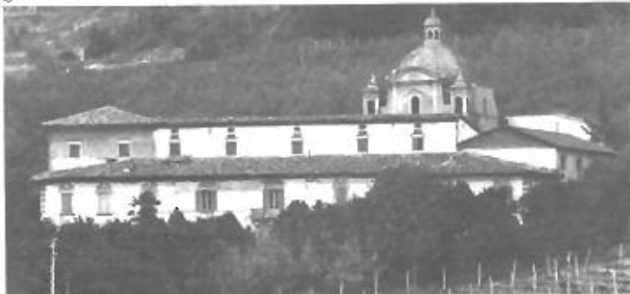
Una panoramica della proprietà Sgariglia. Sullo sfondo la cupola della chiesa del Giosafatti
