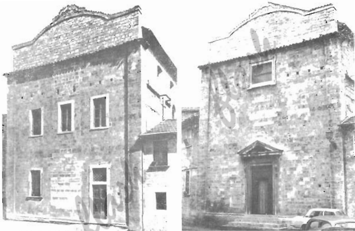
Sopra: le due foto; la chiesa di santa margherita prima e dopo il rifacimento del 1938 ■ A fianco: la Caserma Umberto I° realizzata (con progetto dell'ing. Enrico Cesari) dopo la demolizione del monastero delle Vergini
