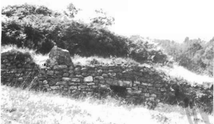
CACIARA N°9 - "a tumulo" - (interno a pianta irregolare con diametro di circa m.1,20 e altezza del vano m.1,50)
