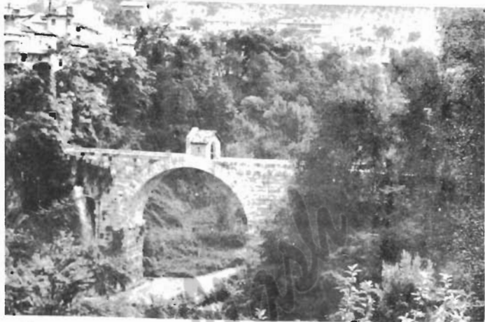
Il ponte ricostruito nel 1971.
