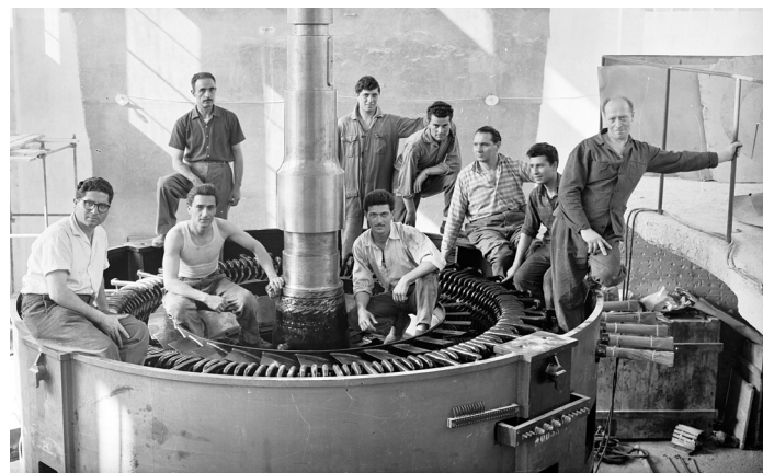
Sopra: gruppo di persone presso la diga di Scandarello, anni Trenta. ■ Sotto: centrale di Porta Romana, operai su un alternatore ad asse verticale, anni Cinquanta, secondo da destra Luciano Zanini.
