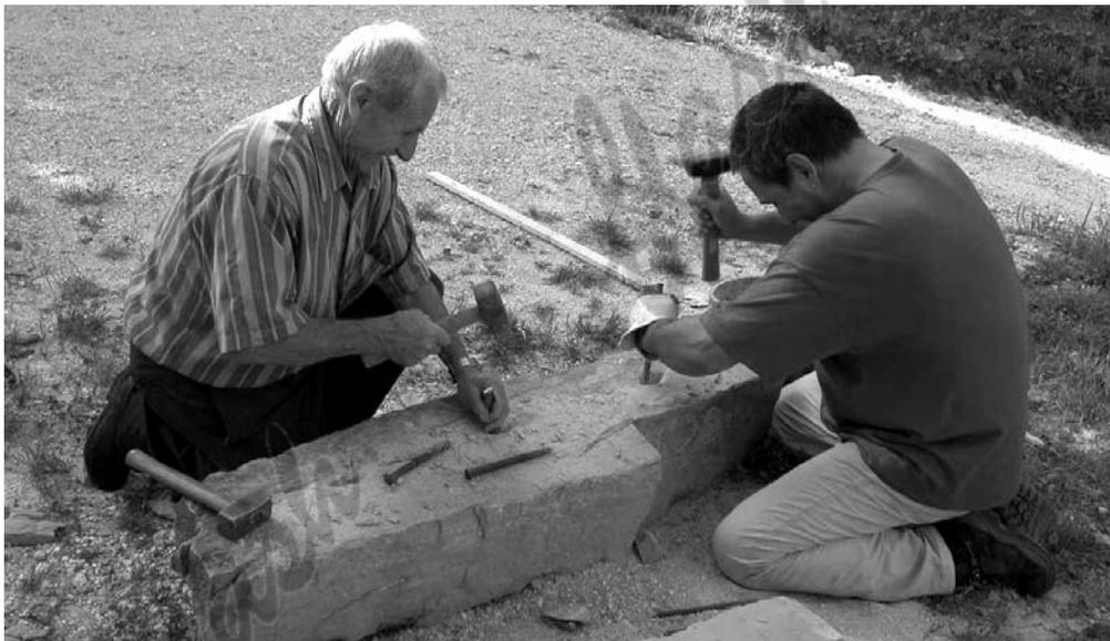
pietra da muro angolare, la conciatura su due facce verticali per la predisposizione di muro a faccia vista e la calibratura dei piani di appoggio orizzontali; la sbazzatura e la conciatura di pietra grezza di forma allungata, per ricavare lo stipite di porte e finestre, la conciatura dei quattro lati lunghi del massello grezzo in senso verticale e la sbazzatura e
