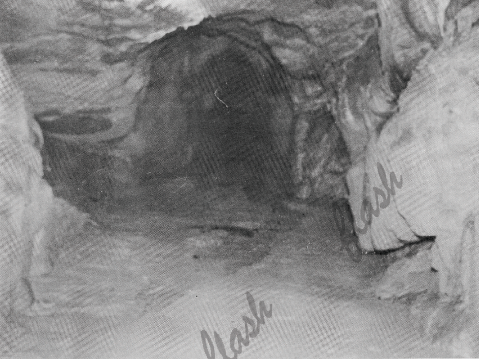
GALLERIA SULLA SPONDA SINISTRA DEL FIUME CASTELLANO: Il tratto dai pressi di Via di Porta Torricella, alla prima briglia a monte. la Galleria percorre, in senso parallelo, la sponda sinistra del Castellano con due diramazioni normali all'asse di scorrimento del fiume. (Rif.8)
