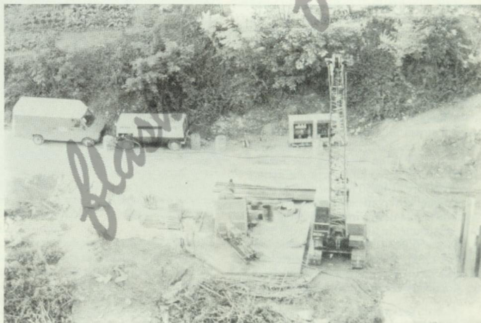
re notevolmente l'area della base d'appoggio della pila.
