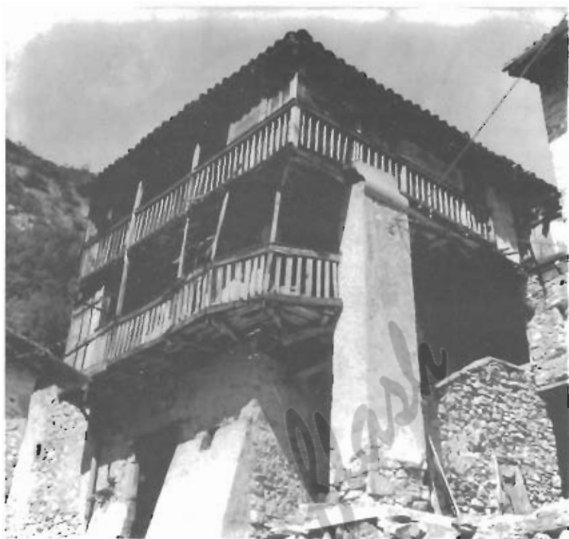
Tipica costruzione del 1801, con due balconi e pilastro di sostegno.
