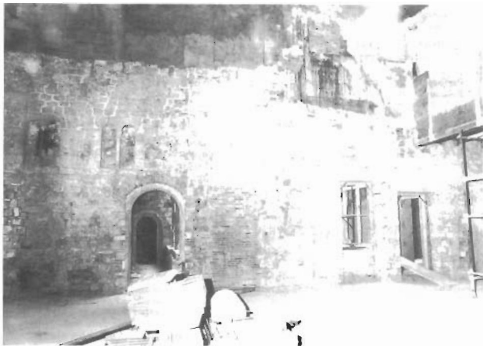
Due locali dell'edificio prima dell'inizio dei lavori. Si notano le tracce (macchie) del precedente intervento di consolidamento. Purtroppo dette tracce, nonché le colle di cemento, hanno richiesto dei massicci interventi di pulizia.
