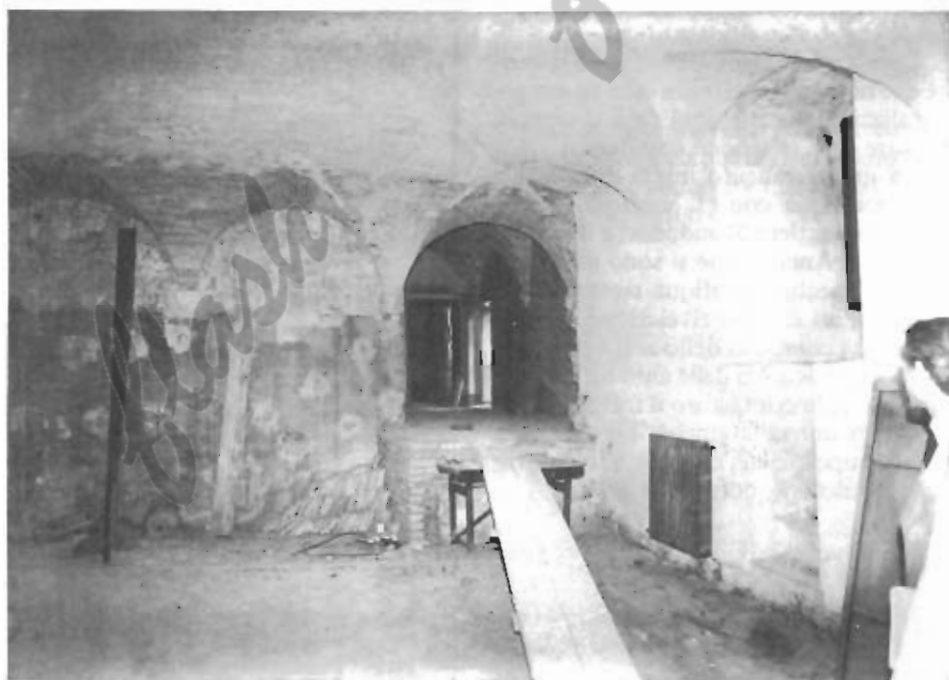
Due locali dell'edificio prima dell'inizio dei lavori. Si notano le tracce (macchie) del precedente intervento di consolidamento. Purtroppo dette tracce, nonché le colle di cemento, hanno richiesto dei massicci interventi di pulizia.
