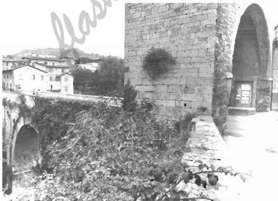
Foto sopra e sotto: evidente la preoccupante "avanzata" dell'erba sul ponte di Porta Cappuccina.
