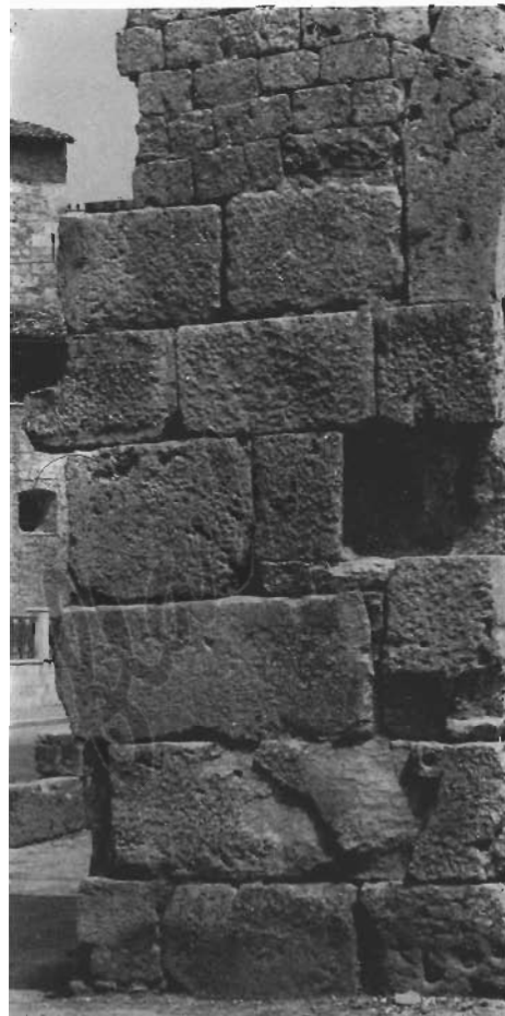
PORTA ROMANA, particolare delle mura.
