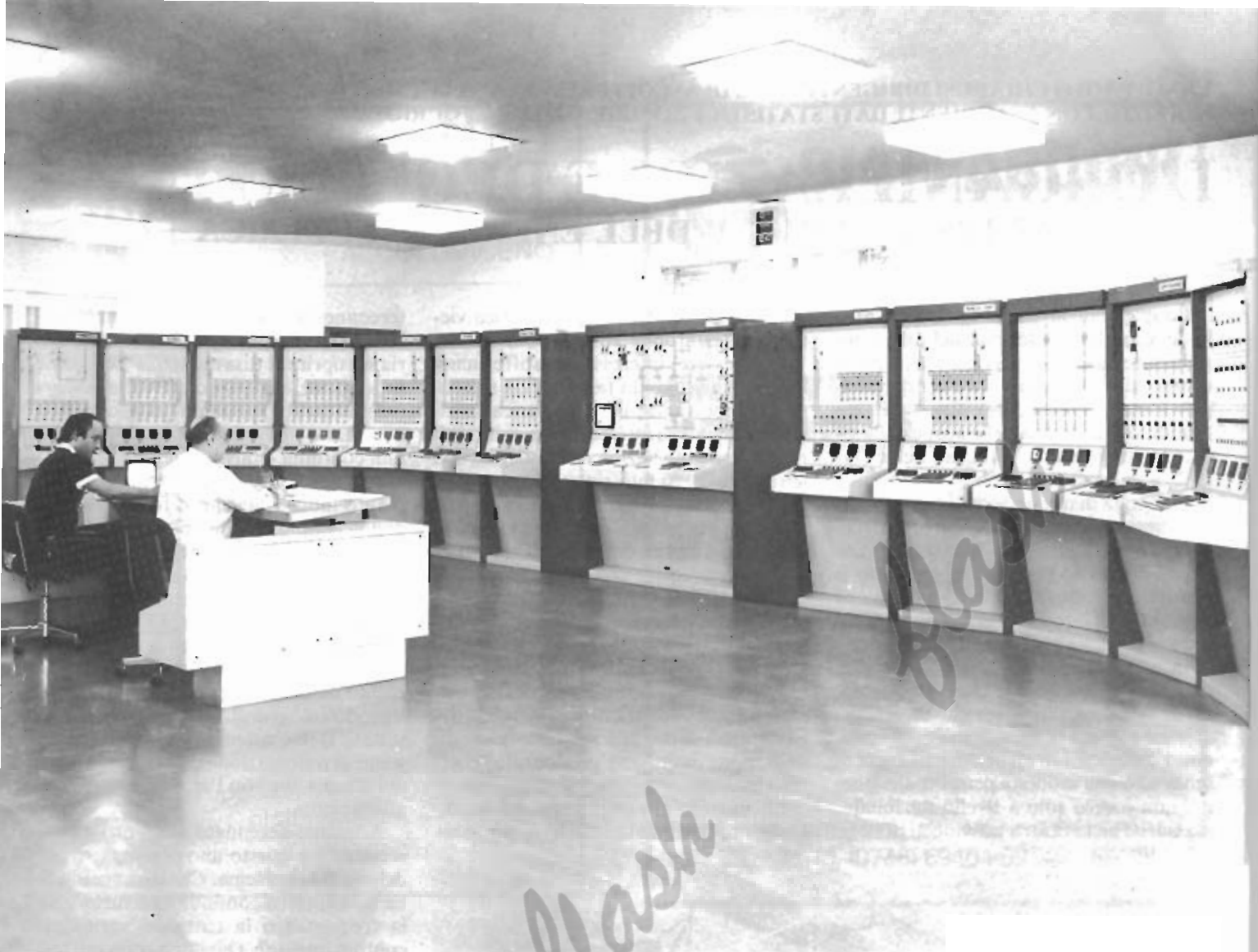
Centro Operativo della Zona ENEL di Ascoli Piceno.
