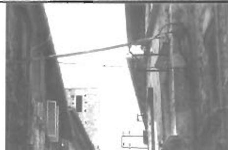
Via dei Soderini - l'élite di Ascoli storica - anche qui lo scempio causato da una sovrapposizione di elementi deturpanti.
