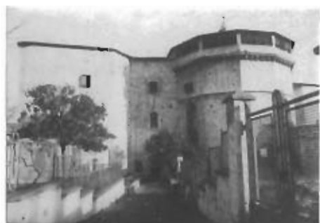
Il Forte Malatesta visto dalla parte dell'ingresso principale.
