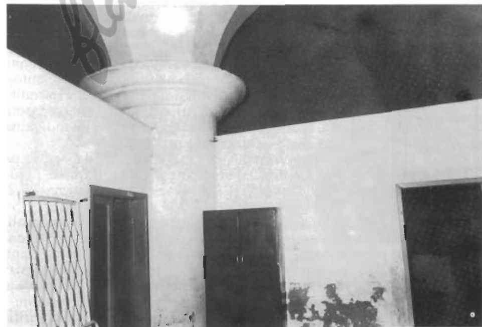
Sotto: La colonna fatta realizzare dal Sangallo per sostenere il primo dei tre piani con i quali il grande architetto riempi il vuoto contenitore cilindrico di S. Maria del Lago.
