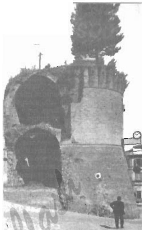
Lo stato attuale del torrione dove era sistemata l'aquila.
