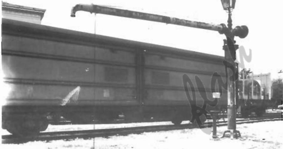
La gloriosa pompa a braccio (o colonna idraulica) per il rifornimento di acqua alle vaporee, oggi in disuso.
