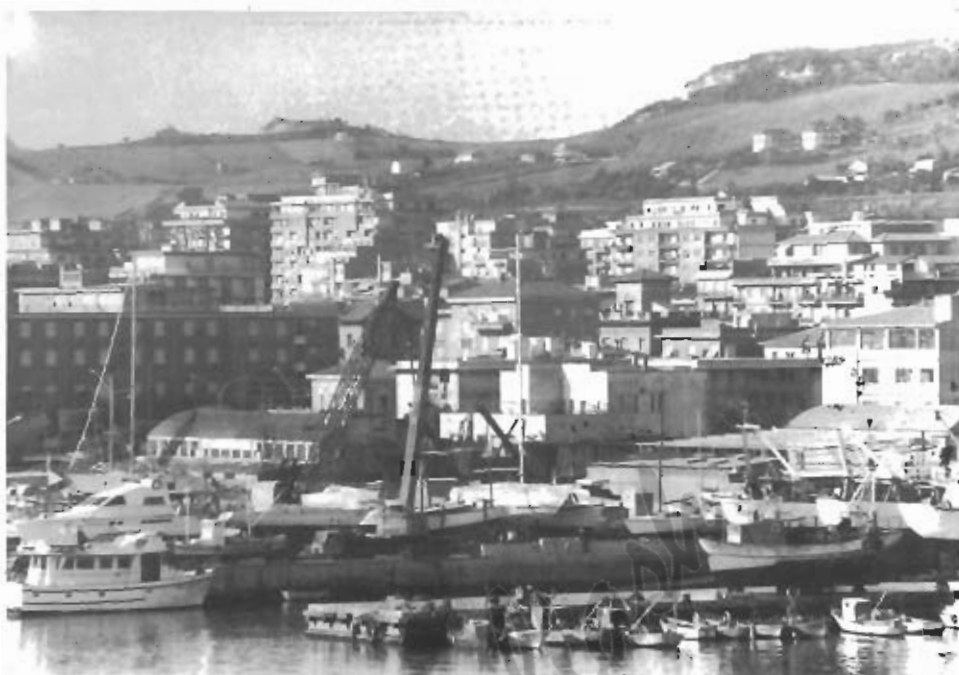
Il cantiere navale di S. Benedetto del Tronto, con scalo d'alaggio. (Foto Sgattoni)
